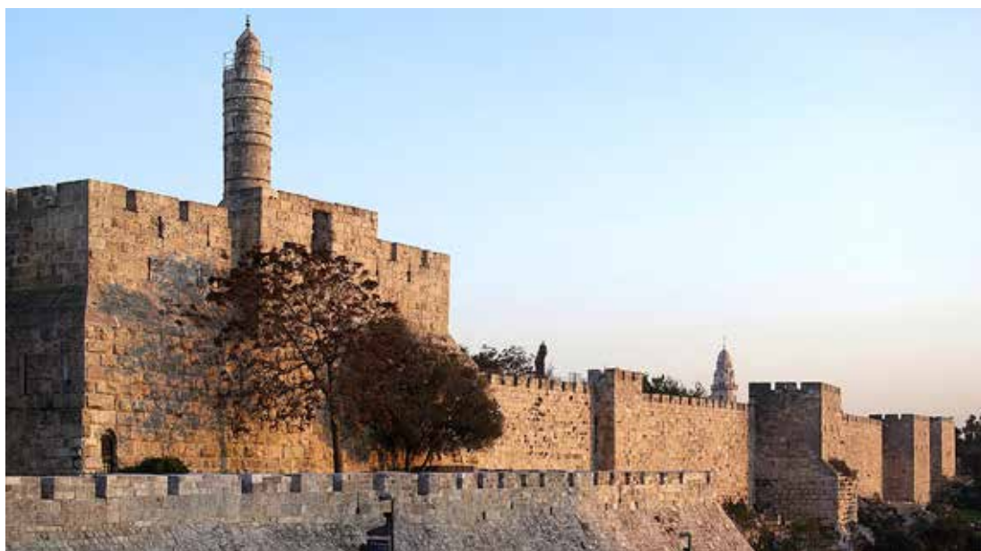
Bymuren som Suleiman den Prægtige lod opføre (foto: Berthold Werner)
