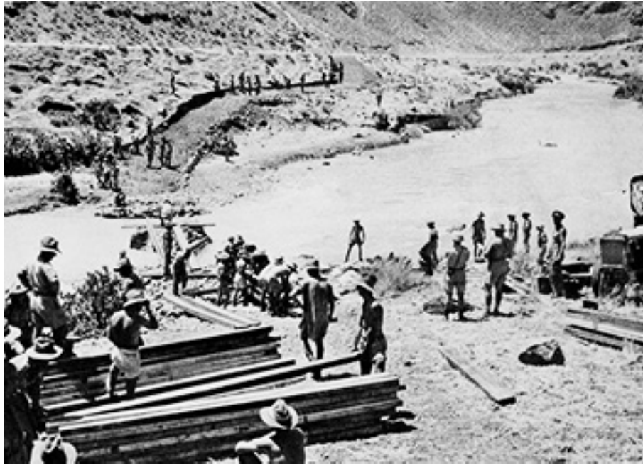
Under Syrien-Libanon-felttoget bygger australske soldater en feltbro over floden Litani i det sydlige Libanon.
